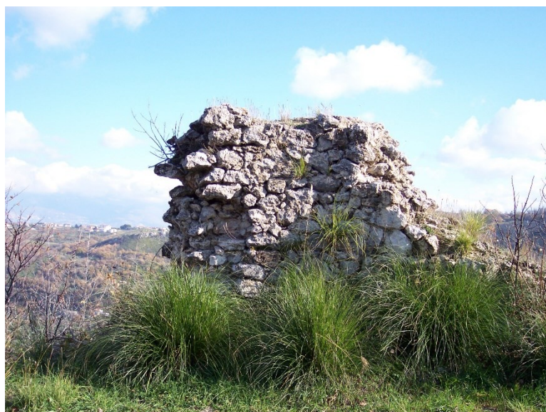
foto 1: Particolare cinta muraria Mendicino vecchio
